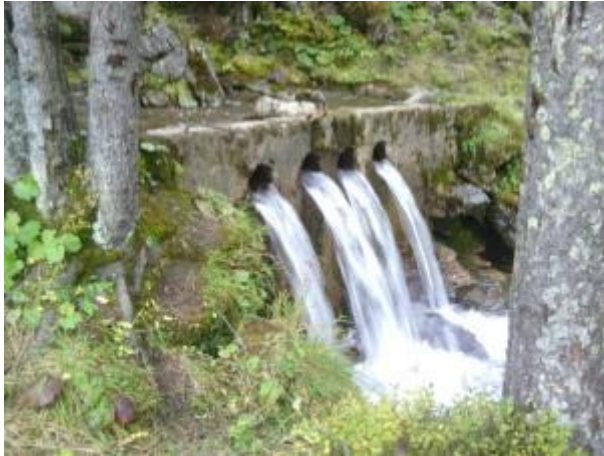
Seuil de stabilisation sur la Dranse de Montriond aux Lindarets
