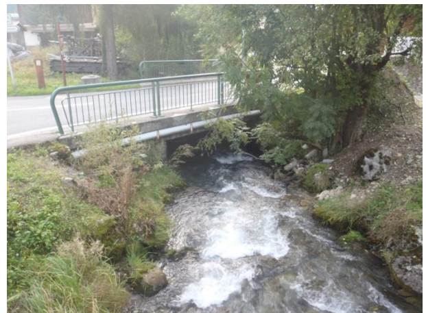
Ouvrage SAI.7 au niveau des Udrezans
