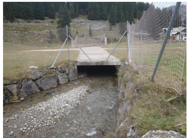
Protections de berge et couverture du lit aux Lindarets
