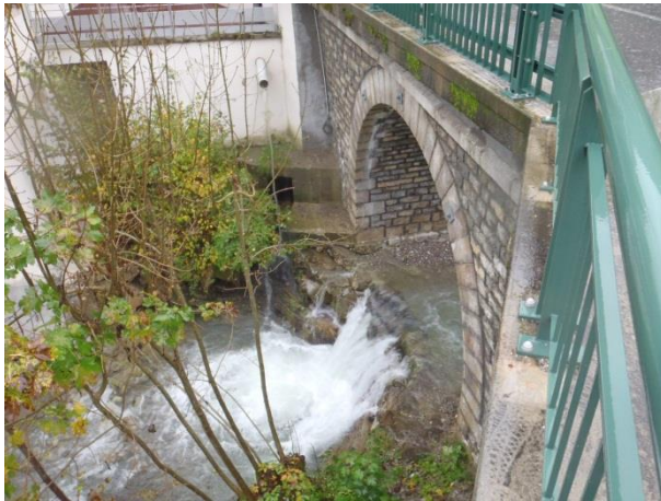
Limitation de la continuité biologique au niveau du Pont de Combe
