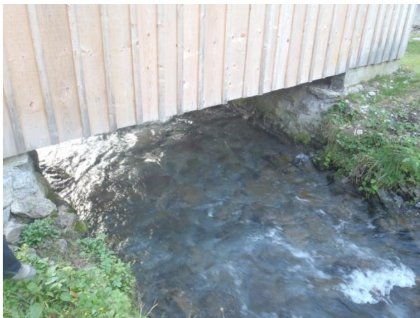
Ouvrage SAI.4 au niveau des Meuniers
