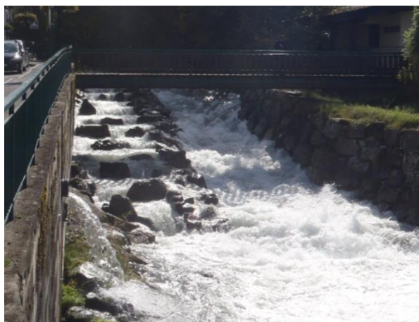
Passe à poissons à bassin successifs à Morzine (DmzT1)
