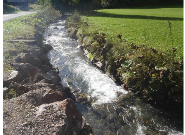
Recalibrage important du torrent au niveau des Crêts
