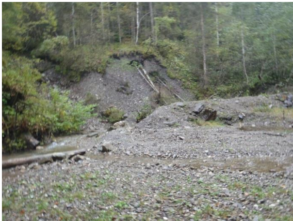
Zone de dépôts et érosion au niveau des Bouts dessous
