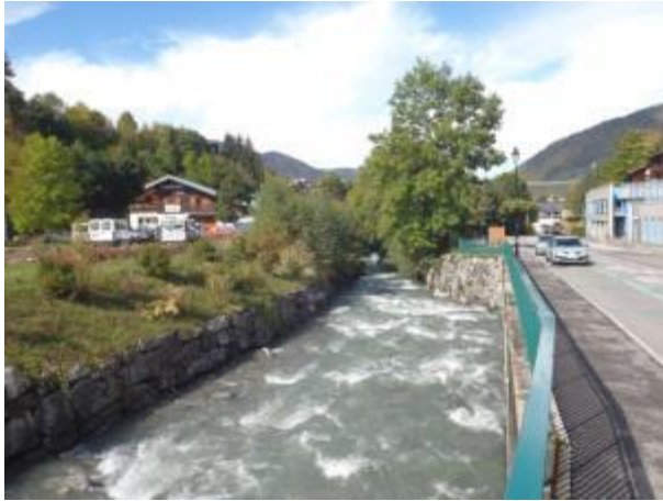
Recalibrage et artificialisation des berges de la Dranse de Morzine dans le centre de Morzine
