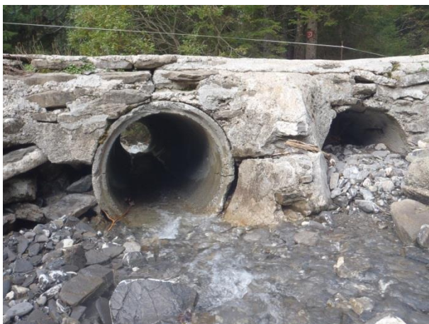
Section de l'ouvrage DMA.1 semi-comblée
