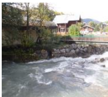
Prise d'eau d'ancien Moulin/Scierie sur Morzine (DmzT1)
