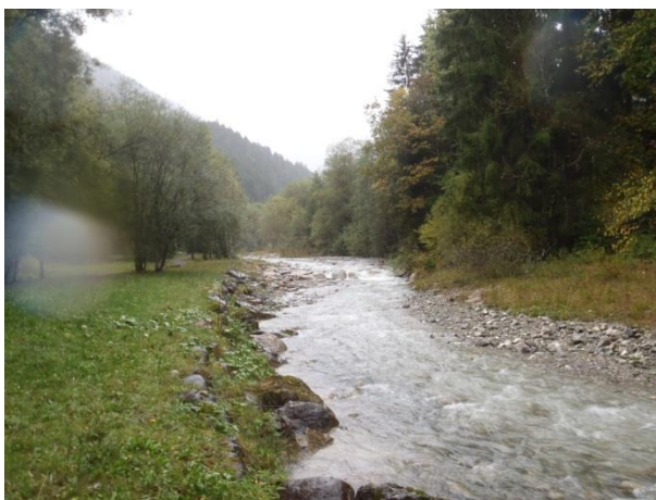
Lit stabilisé mais sujet aux atterrissements en amont du Pont de Combe
