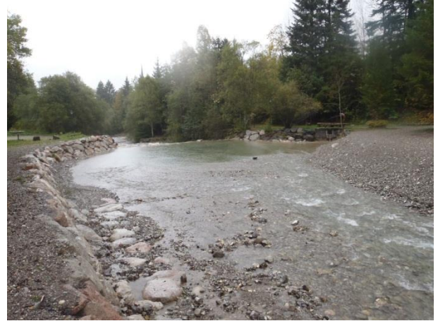
Queue de retenue du seuil de stabilisation des Mudry
