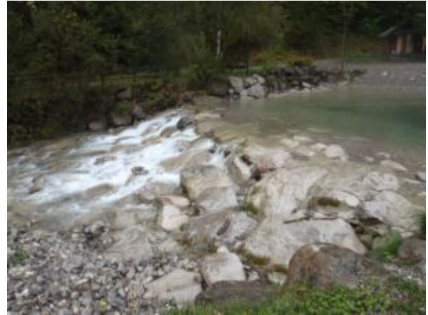
Seuil de stabilisation et plage de dépôt associée sur le Seytroux (SeyT3)
