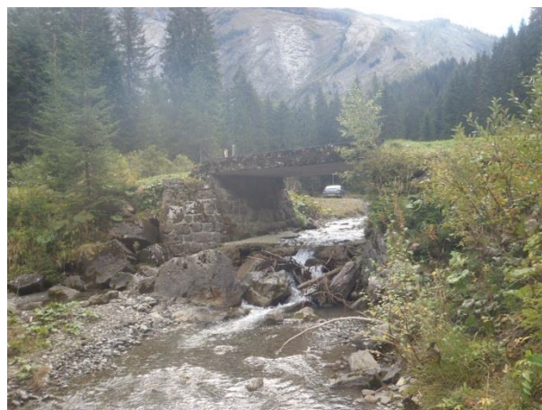
Radier du Pont d'accès à Vigny (Dma.2)
