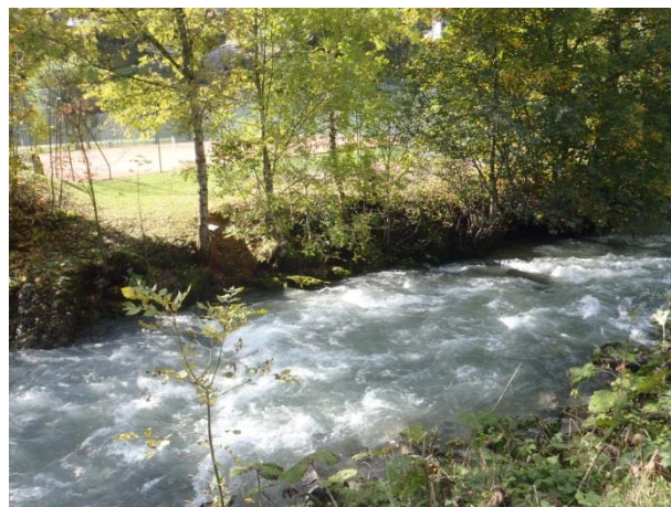
Banalisation des écoulements au niveau du tronçon DMZ.1
