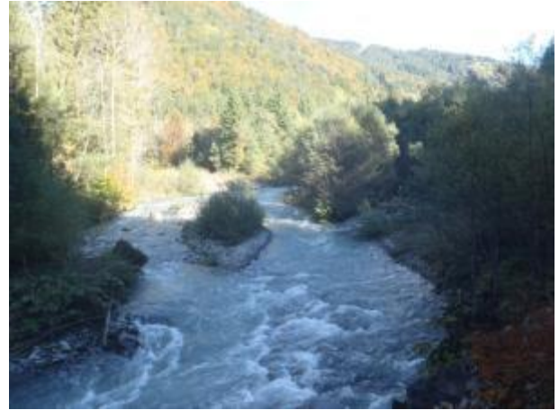
Retour de quelques zones mobiles dans la traversée de Montriond
