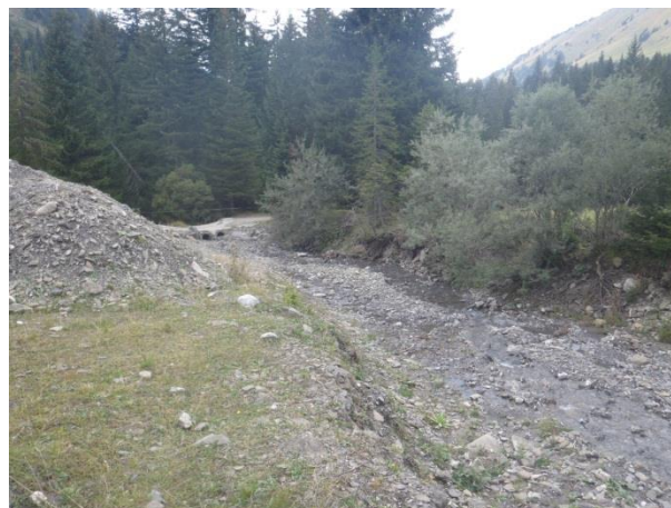
Curage des matériaux en amont de l'ouvrage
