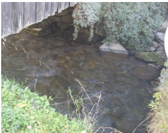
Effet de pavage du fond dans un secteur recalibré
