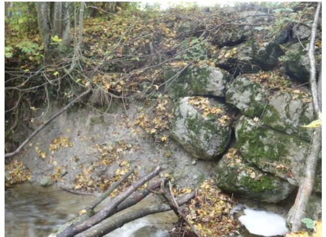
*Erosion de berge caractérisée en aval d'une protection en enrochements (MAR2/MAR3)*
