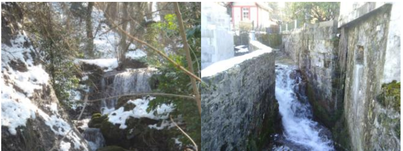
Seuils de stabilisation sur le ruisseau de Forchez
