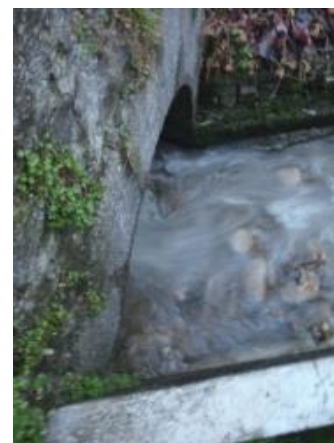
Ouvrage MON.6 en amont de la D21
