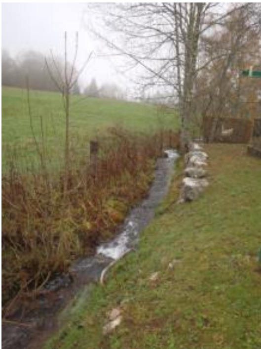
Protections en enrochements à Thollon-les-Mémises
