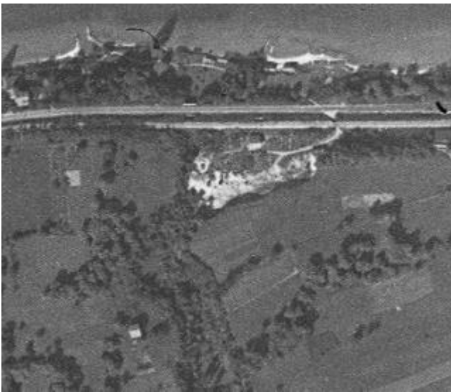
Ruisseau de la Carrière au droit de la Carrière la Maladière en 1934
