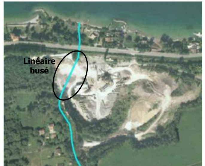
Ruisseau de la Carrière au droit de la Carrière la Maladière en 2008
