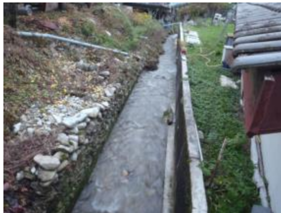
Artificialisation des berges du ruisseau en amont du pont de la D21
