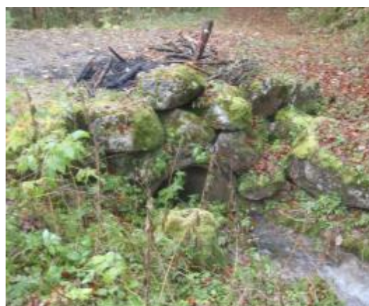
Ouvrage MOR.2 au niveau de la Planche
