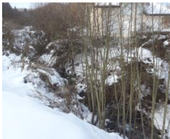
Encassement du lit du ruisseau
