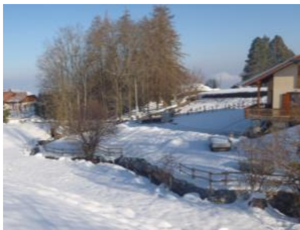
Protections de berges au niveau de Poëse
