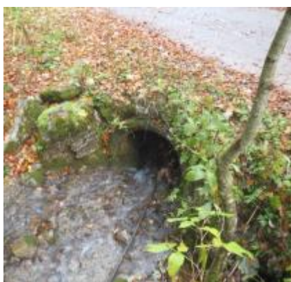
Ouvrage MOR.1 au niveau de l'Enclos
