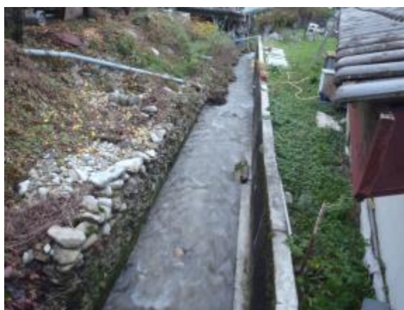
Artificialisation du lit sur l'unité MON.2
