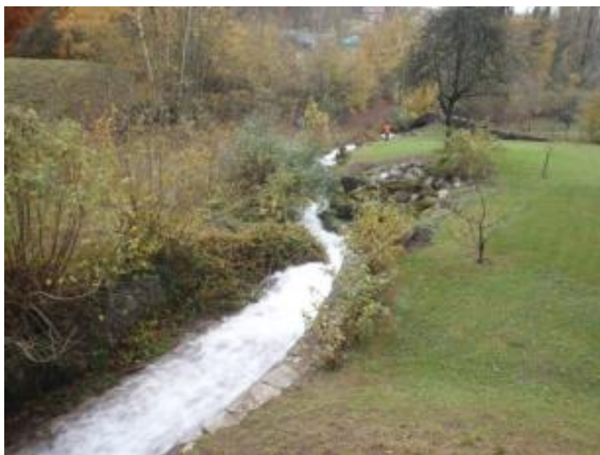
Protections de berges au niveau de la Tière
