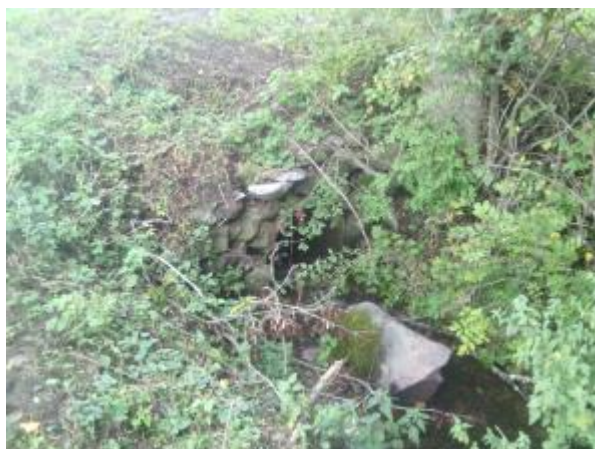
Ouvrage COP.1 au niveau de Roseires d'Aval
