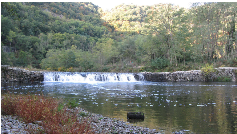
Barrage de Valendy avant travaux (octobre 2016)
