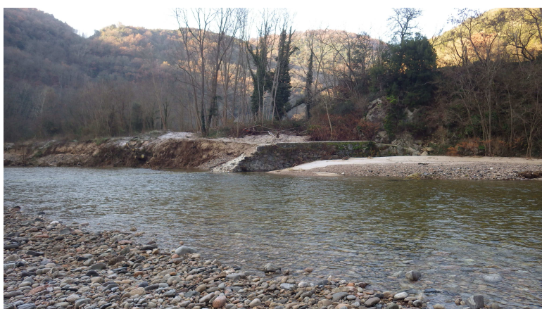
Secteur du Barrage de Valendy après travaux (décembre 2016)
