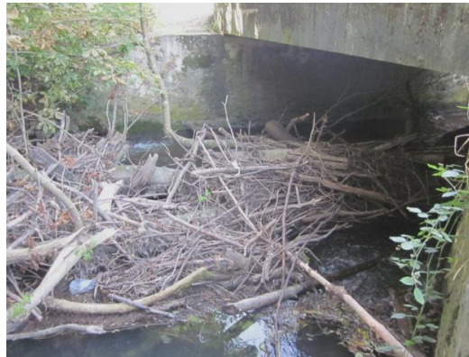
Figure 24: Embâcles sur le Petit Morin. Les embâcles sont des accumulations de débris végétaux entravant plus ou moins l'écoulement des eaux (Source : EDATER)
