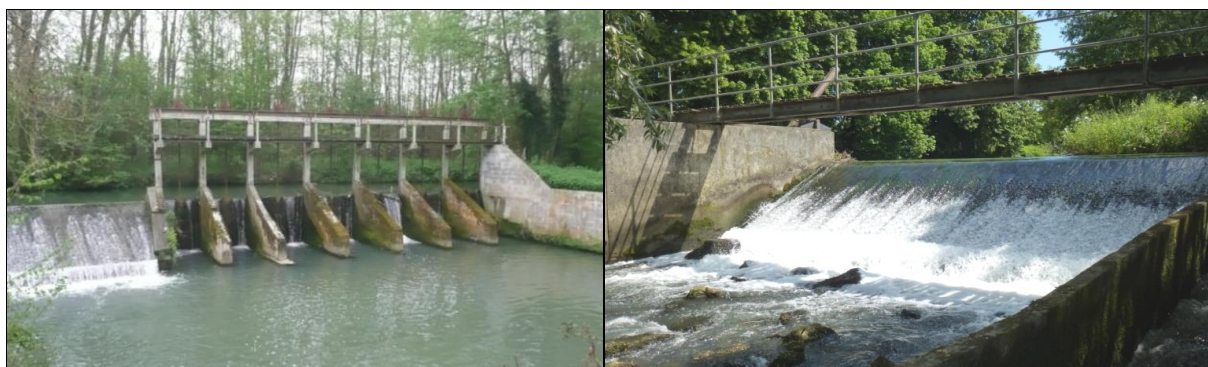
Figure 15: Ouvrages hydrauliques. A gauche : Vannage de Montblin à la Ferté-Gaucher ; A droite : Ouvrage de la coutellerie à Mouroux (Source : SIVHM)
