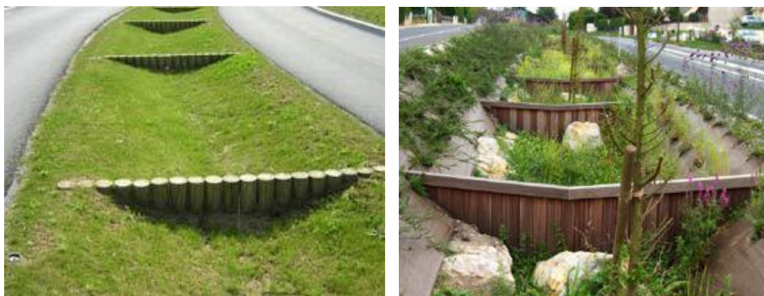
Figure 26: Noues pouvant prendre l'aspect de fossés enherbés où les eaux pluviales sont collectées, stockées et infiltrées (Source : ville de Montendre, SIVHM)
