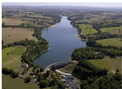
Photo 1 : barrage de la Roucarie
