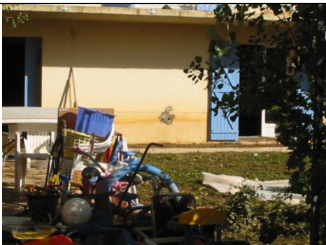
Rue Apollinaire, traces du niveau d'eau, 17 novembre 2011
