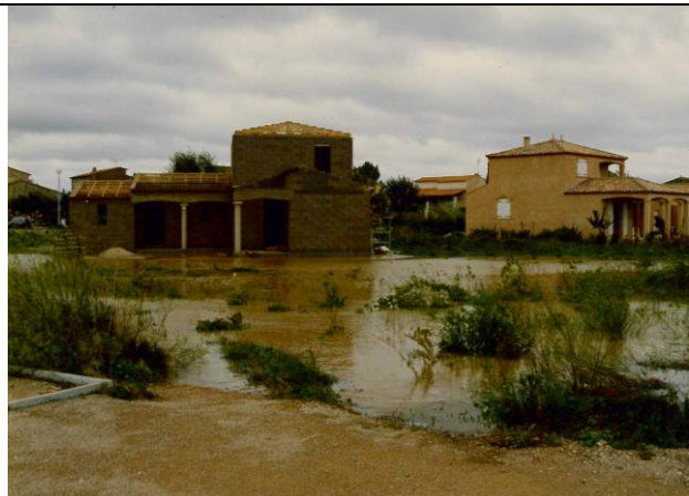
Lotissement de l'Esplanade, crue du Dardaillon Ouest, 21 septembre 1994
