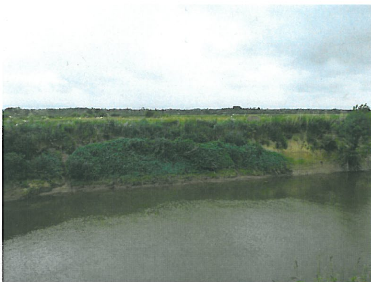
Figure 1 : digues en voie d'affaissement (secteur amont)
