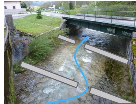
Figure 11 : Schéma de principe des barrettes sur le radier de l'ouvrage 36805
