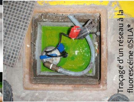
Traçage d'un réseau à la fluorescéine ©SILA\*
