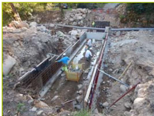
Destruction du passage à gué busé et remplacement par un passage à gué franchissable par les poissons et les cailloux (photo du 23/10/2018)
