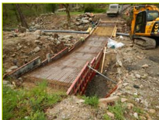
Reprise du chantier après l'hiver : période de hautes eaux et de sensibilité des poissons (photo du 16/04/2019)
