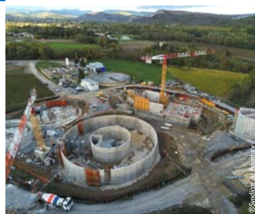
Chantier de la station d'épuration d'Aubenas - novembre 2019.
