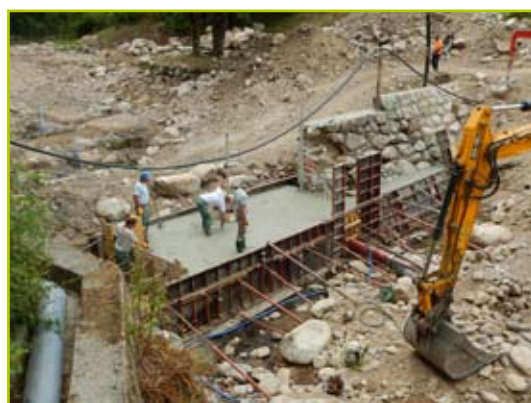
Fabrication d'un dispositif de fermeture temporaire du plan d'eau pour l'été avec des palplanches amovibles (photo du 15/07/2019)
