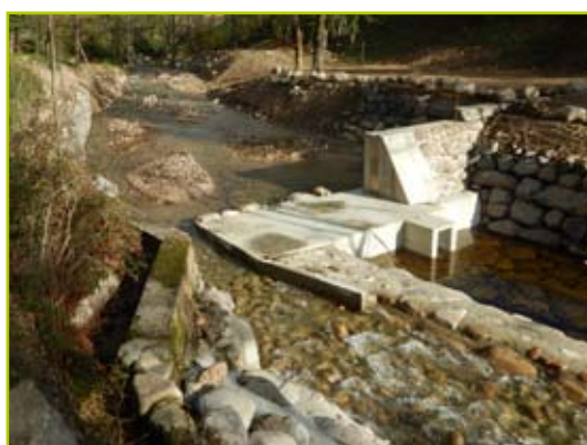
Construction d'une rampe piscicole en enrochements, stabilisation des berges (photo du 06/11/2019). Phase de restauration de la ripisylve à venir.
