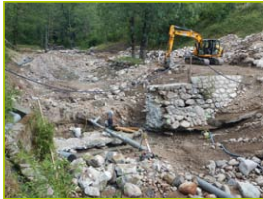
Ouverture partielle et abaissement de la crête du barrage. Pendant le chantier, l'eau de la rivière s'écoule dans la conduite grise (photo du 20/06/2019)
