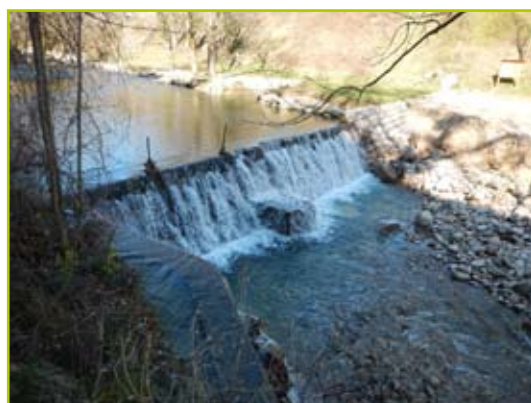
Plan d'eau - situation avant travaux (photo du 21/03/2018)
