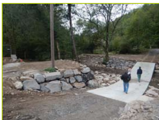
Passage à gué - situation après travaux (photo du 10/09/2019)
