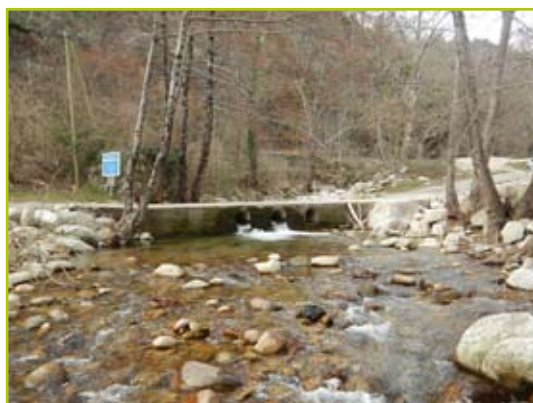
Passage à gué à l'aval du plan d'eau - situation avant travaux (photo du 14/02/2018)
