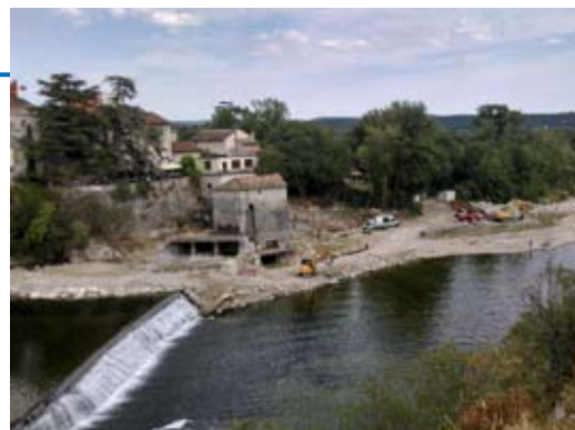
Chantier de la passe à poissons de Ruoms - juillet 2019.
