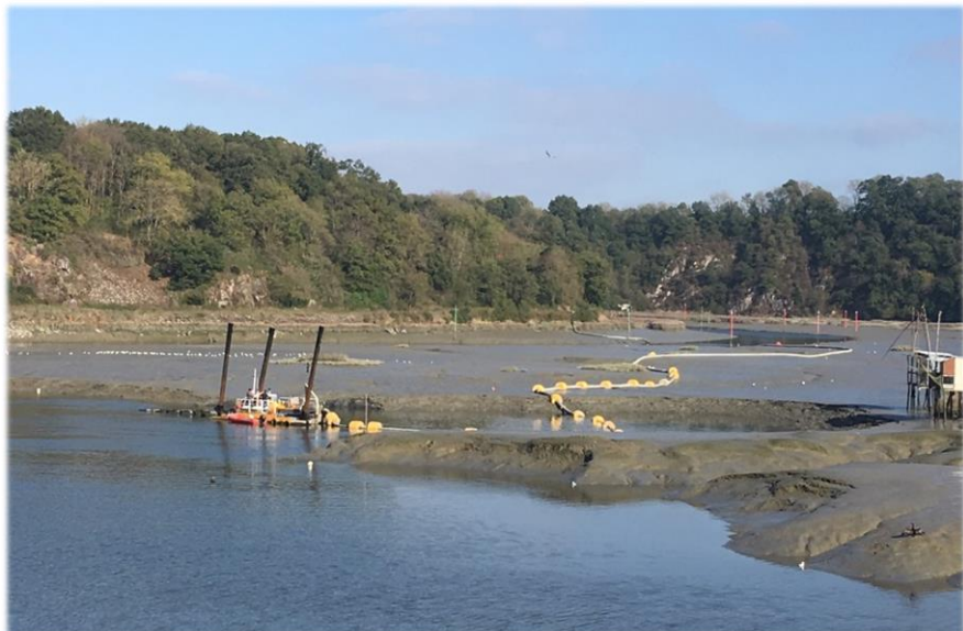
Dragage de sédiments sur le site de piégeage du Lyvet (La Vicomté-sur-Rance). Les sédiments extraits sont ensuite amenés sur la plateforme de transit de la Hisse à Saint-Samson-sur-Rance pour décantation et séchage.
