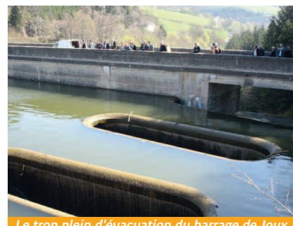
Le trop plein d'évacuation du barrage de Joux
