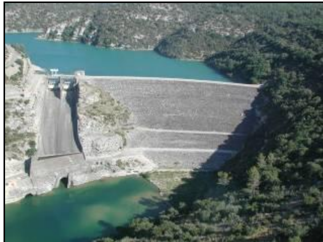
Le barrage de Gréoux
