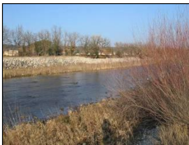
Protection de berge à Vinon-sur-Verdon
