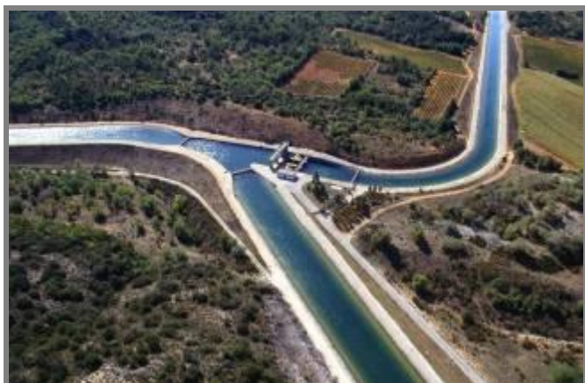
Prise de Boutre, départ du Canal de Provence
