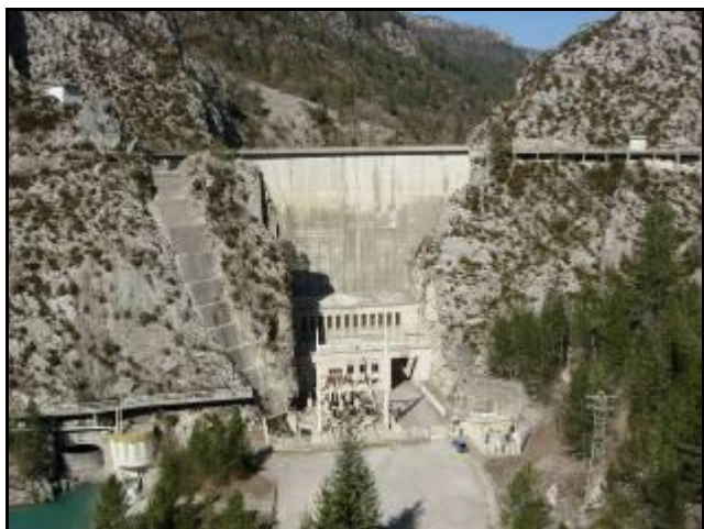
Le barrage de Chaudanne
