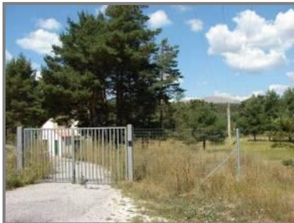
Captage d'eau potable
