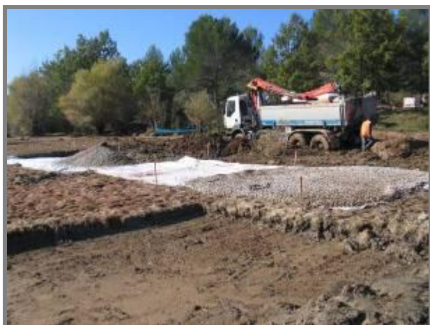
Chantier de mise en œuvre de placettes expérimentales des méthodes de gestion de l'herbier
