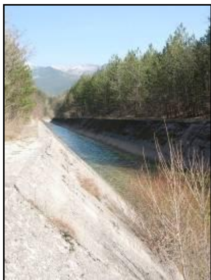
Canal de fuite de Chaudanne
