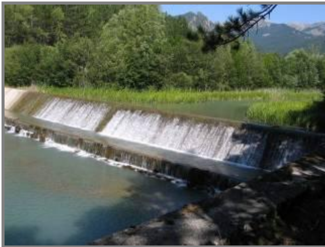
Seuil infranchissable à Castellane
