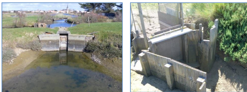
Vues de différents types d'essailles (en béton à gauche ; en bois à droite)
