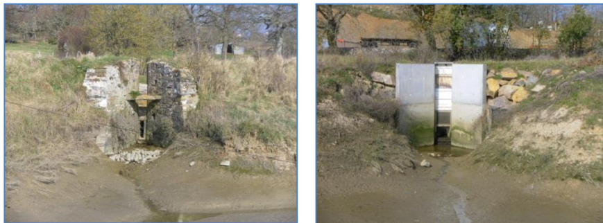
Les essalles sont souvent en pierres et dégradés, ou parfois plus récents en béton
