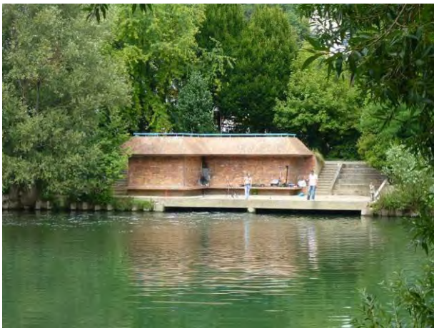
Figure 49 : Exutoire de la station d’épuration de Marne Aval à Champigny
