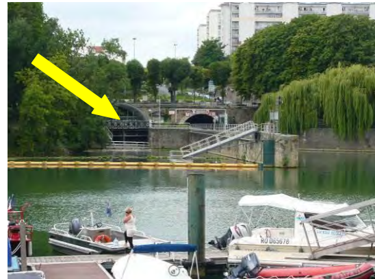
Figure 17 : Prise d'eau de l'usine de Joinville
