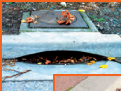
Bouche d'eaux pluviales
