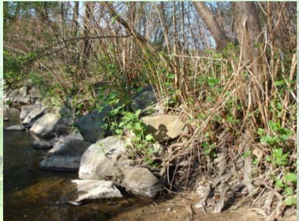
Les bancs de galets et les empierrements de berges
