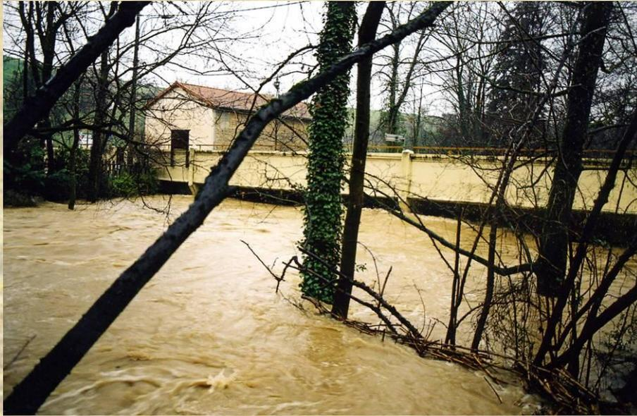
**Mise en charge entraînant une réhausse des lignes d'eau en amont**
