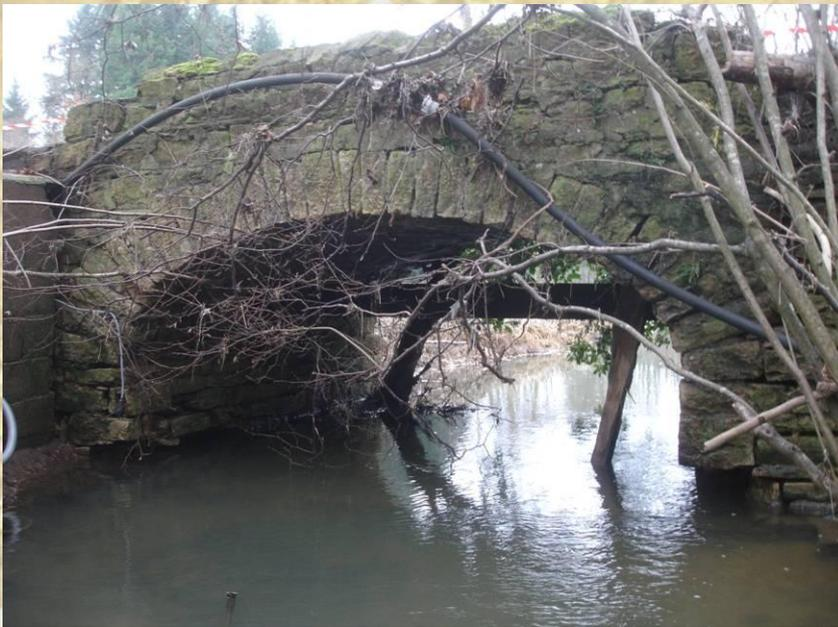
**Ouvrages sous-dimensionnés et/ou en partie obstrués**
