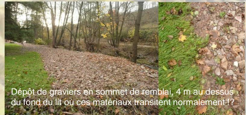
↳ réduction de la section d'écoulement et du champs d'expansion des crues
