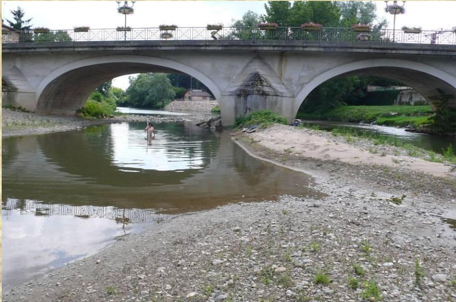
Dépôt des matériaux dans le remous en aval des piles
