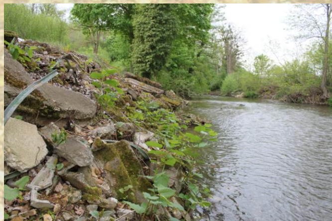
Remblaiement de la berge en rive droite par des matériaux de démolition
