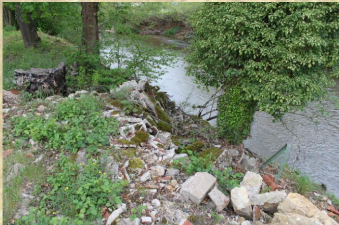
Remblaiement de la berge en rive droite par des matériaux de démolition
