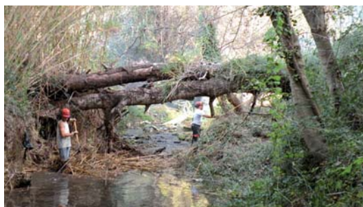
Travaux d'entretien de la rivière
