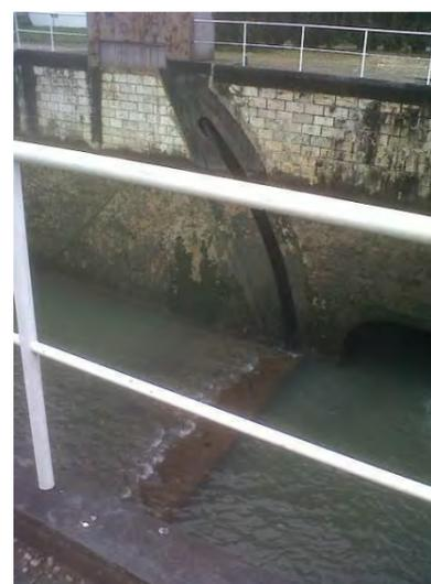
Figure 74 : vue de l'avant sas de l'écluse de Saint Maur avec la « vanne secteur » coincée en position « baissée »
