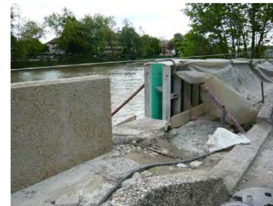
Figure 71 : Murette en construction quai Ferber à Bry pour une protection décennale
