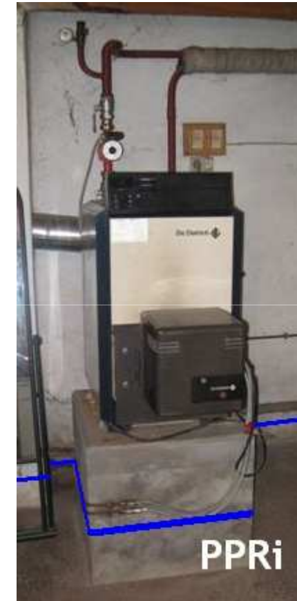
Rehausse de chaudière...
