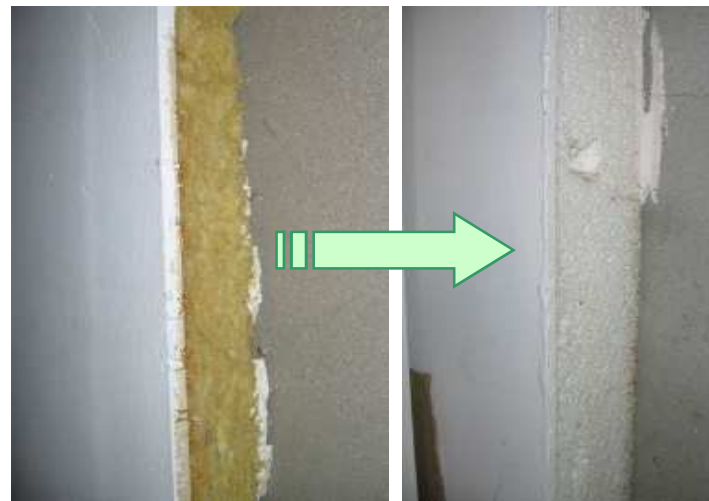
Changement des matériaux d'isolation
