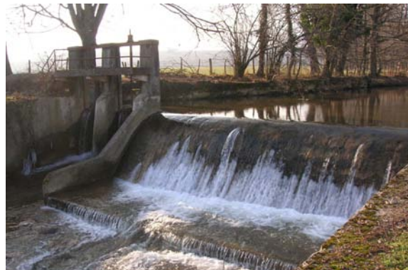
Seuil sur l'Ardières, SMRB, 2006
