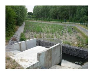
L'eau chargée en pollution se répartie ensuite sur la surface du filtre et percole à travers celui-ci avant de rejoindre les drains situés au fond de l'ouvrage puis le milieu naturel.
