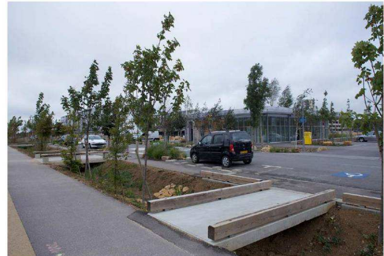
Récupération des eaux de pluie, de la toiture aux fossés jusque dans le canal, rue Henry Brun, Nancy
