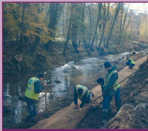
Restauration de berge en technique végétale
