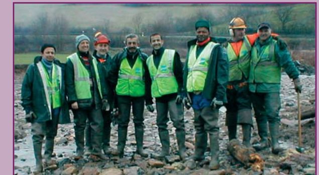
La B.V. 20 sur un chantier post crue
