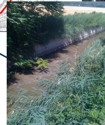
Section type 3 m de large x 2 m de profondeur
