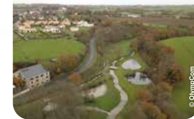
Site de Pinteu après travaux
