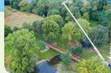
Pose d'une passerelle (Raz Gué)
