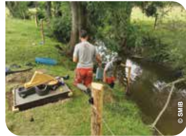
Pose de clôtures et abreuvoirs
