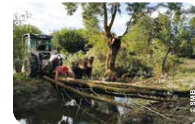
Restauration de la ripisylve
