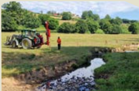
Pose de clôtures sur les Equetteries
