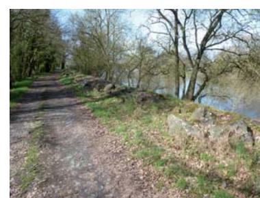
Levée du Petit Louet : enrochements
