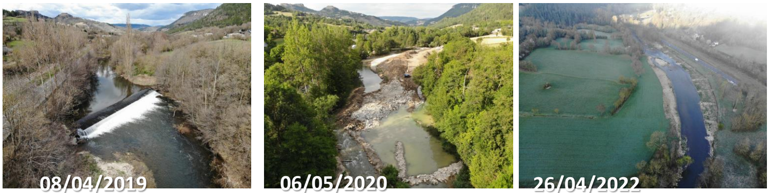
Figure 13 : Le seuil du Moulin de France (avant / pendant et après travaux)
