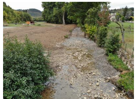
Figure 17 : Seuil du Coulagnet effacé (10/2019) - SMLD
