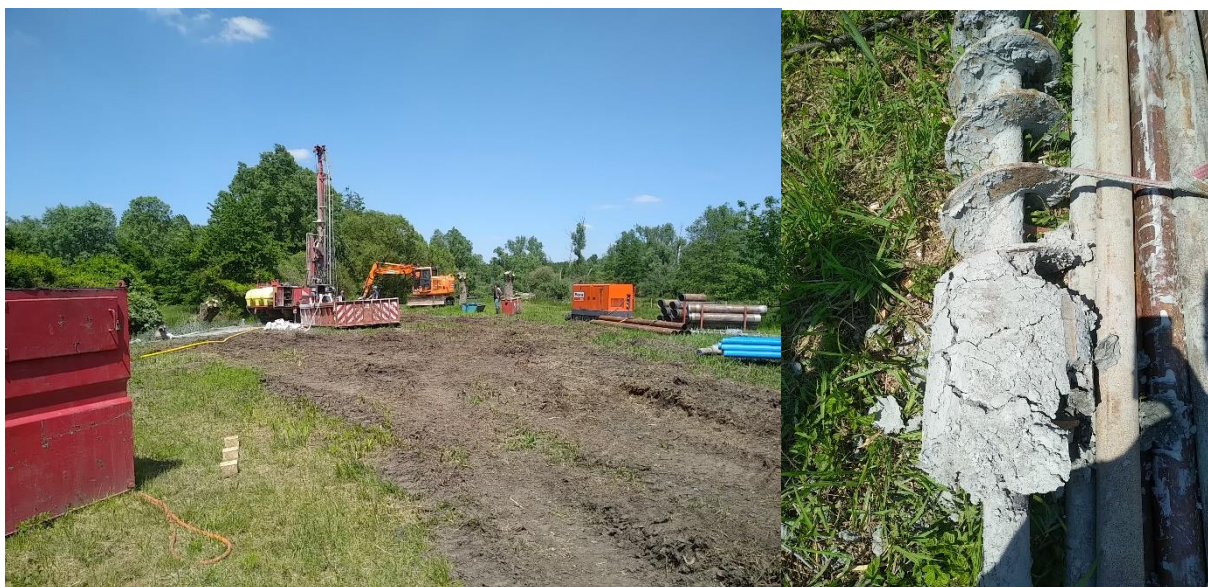
Figure 11 : Photographies prises le 31/05/2021 lors de la foration du piézomètre dans la craie en bordure de la tourbière de Vred ( BSS004CFVG ). Plan général à gauche, argiles de Louvil sur la tarière à droite.
