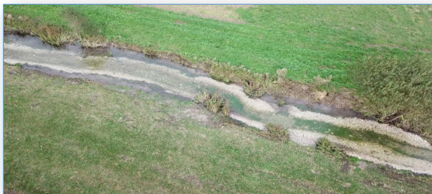
Figure 16 : Vue aérienne du lieu-dit « les Nivards » sur le Pouzat après travaux- 2019
