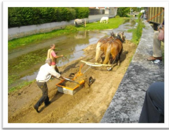
FIGURE 51: TRAITEMENT DES ATTERRISSISSEMENTS PAR TRACTION ANIMALE A IS SUR TILLE
