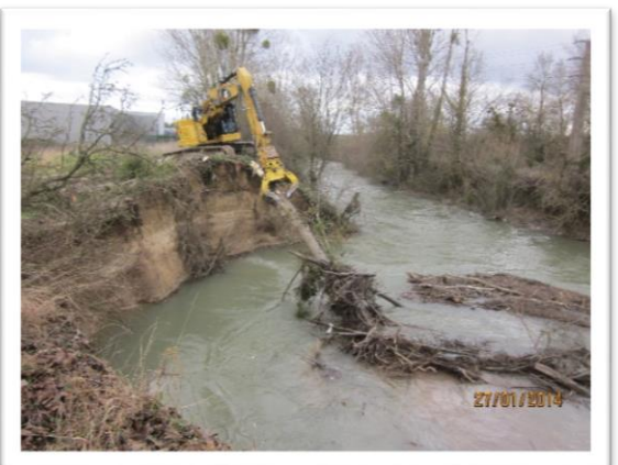
FIGURE 50: TRAVAUX DE RETRAIT D'EMBACLES
