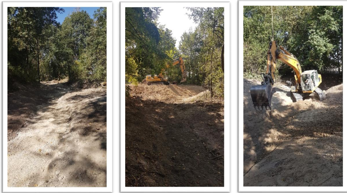
FIGURE 34: REPROFILAGE DES BERGES ET RETRAIT DES « BOUCHONS » AMONT ET AVANT DE L'ANCIEN MEANDRE DE LA TILLE A SPOY
