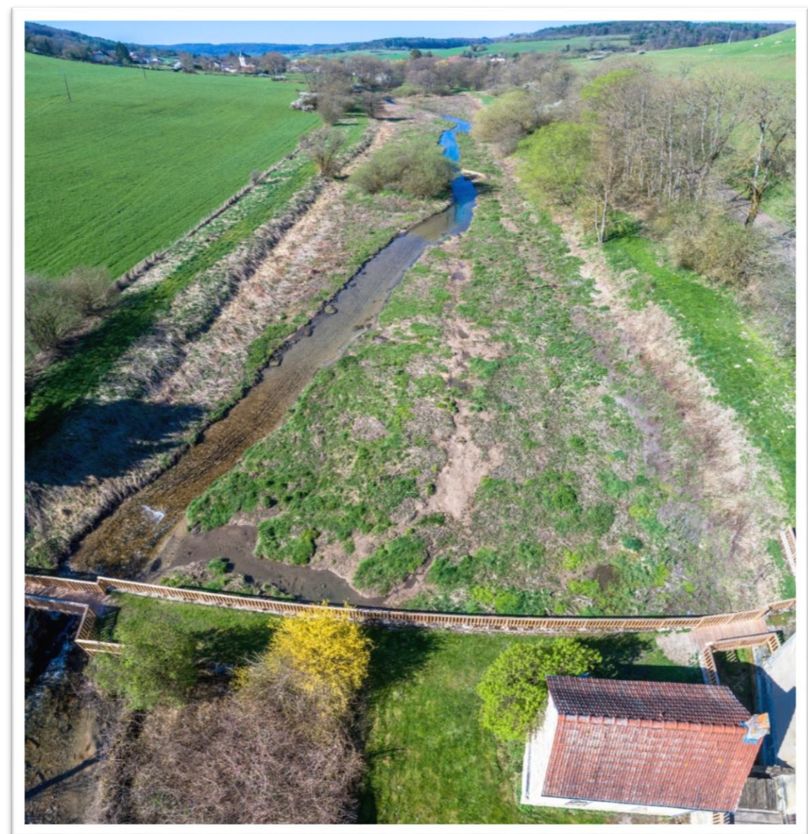
FIGURE 55: L'IGNON RESTAUREE (BAS – APRES TRAVAUX) DANS LA RETENUE (HAUT – AVANT TRAVAUX) DU BARRAGE DU MARTINET DEMANTELE A PELLEREY
