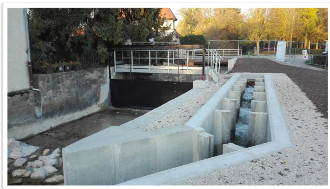
FIGURE 56: BARRAGE DE COUTERNON MODERNISE ET EQUIPE D'UNE PASSE A POISSONS
