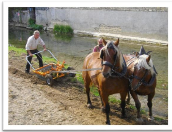
FIGURE 51: TRAITEMENT DES ATTERRISSISSEMENTS PAR TRACTION ANIMALE A IS SUR TILLE
