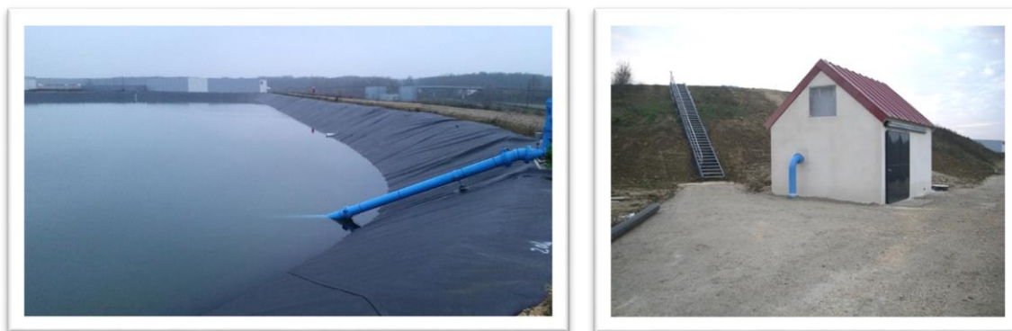
FIGURE 79: BASSIN DE LA BOULOUZE A FAUVERNEY
