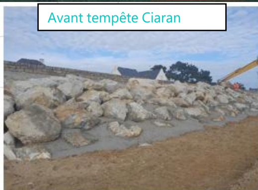
Travaux d'urgence avant 1 er novembre 2023
