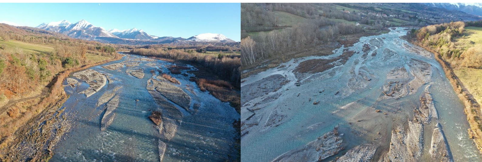
Survol Drone du Drac après travaux © ETRM
