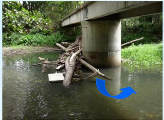
*Pile de passerelle risquant d'être déchaussée puis déstabilisée suite à l'affouillement causé par l'embâcle.*
