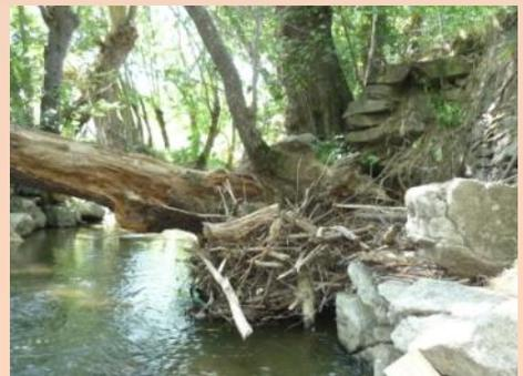
*Cet arbre tombé en travers du cours d'eau est à l'origine d'un embâcle qui provoque une érosion de la berge (chute progressive du mur de soutènement)*
