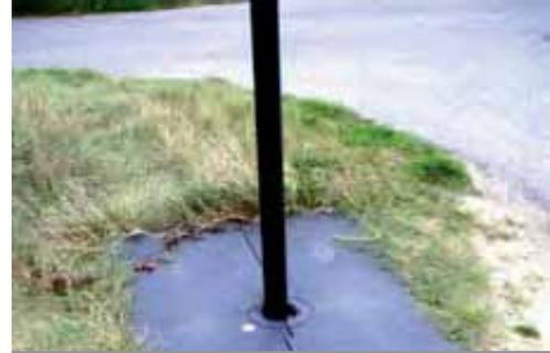
Dans le cadre de l'opération Grand site, on vise la suppression du désherbant. Des plaques de PVC recyclé évitent l'usage de produits chimiques entre la Pointe aux oies et le pont de la Slack.
