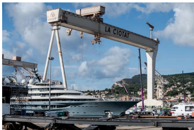
Chantier naval – La Ciotat @François MOURA - MAMP
