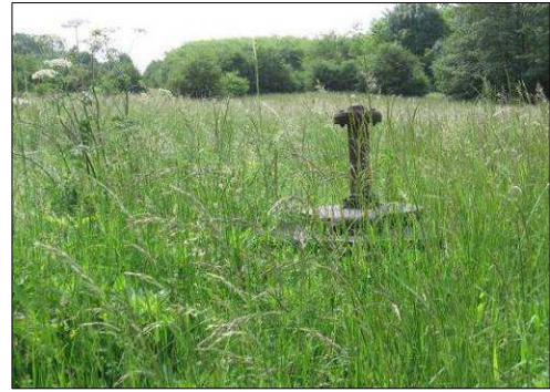
Captage de Lironcourt
