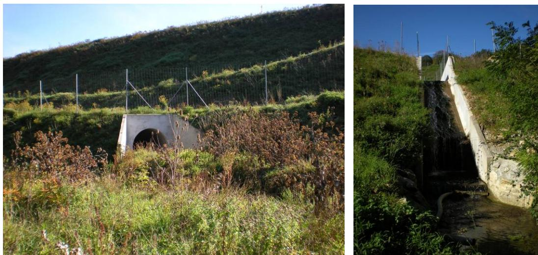
Figure 26 : Passage busé sous l'autoroute et chute en aval immédiat sur le ruisseau d'Aujeurres (Source : EPTB Saône et Doubs)
