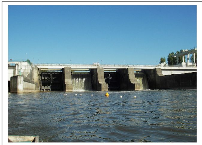
Photo 10 : Barrage EDF de Villeneuve sur Lot
