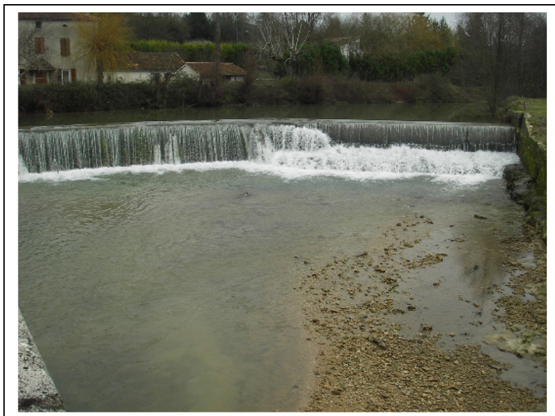
Photo 12 : Ouvrage sur le Boudouyssou, Penne d'Agenais
