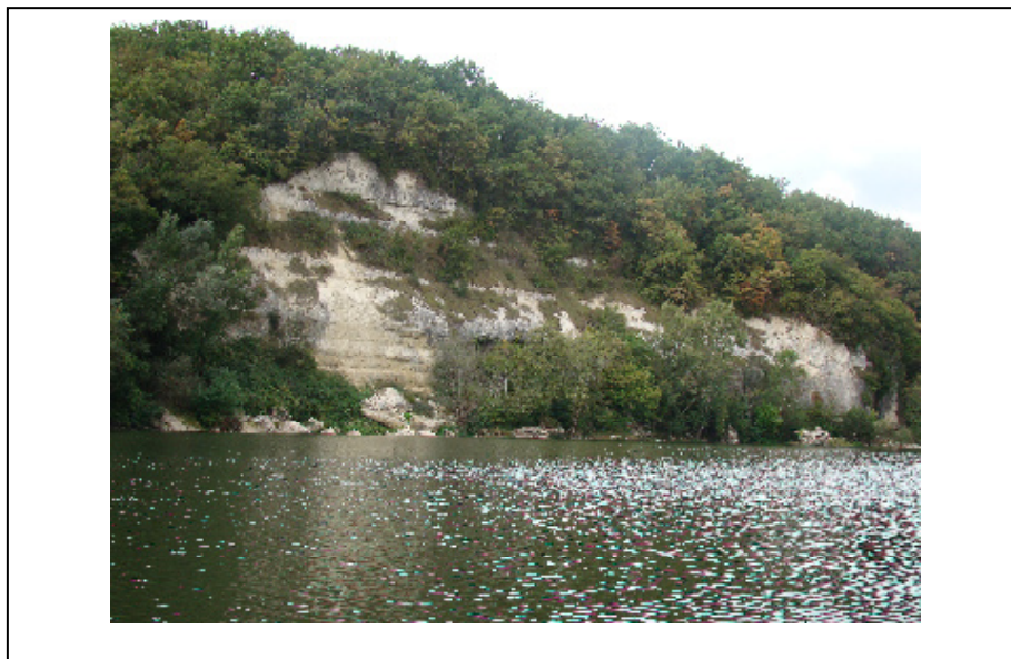
Photo 2 : falaise calcaire à Lustrac (commune de Trentels)
