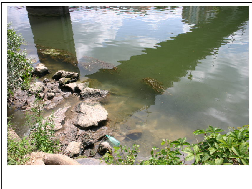
Photo 18 : rejet direct à l'aval du pont de Bastérou, Villeneuve sur Lot (photo : J.Magne, entente vallée du Lot)
