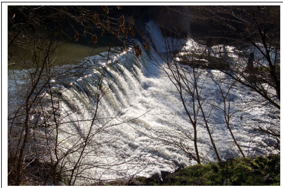
Photo 13 : dernier ouvrage sur la Lède, hauteur de chute de 7m
