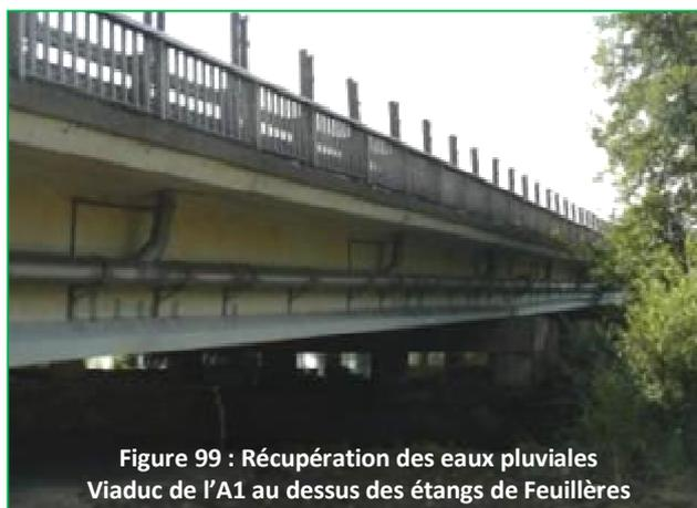
Figure 99 : Récupération des eaux pluviales Viaduc de l'A1 au dessus des étangs de Feuillères
