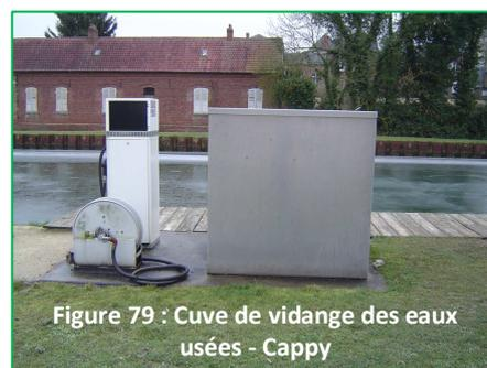
Figure 79 : Cuve de vidange des eaux usées - Cappy
