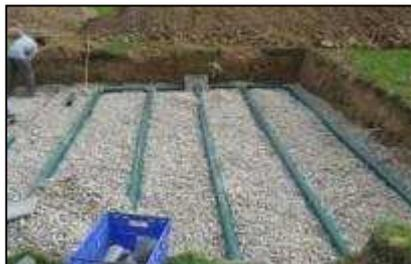
Figure 90 : Mise en place d'un dispositif de traitement individuel (CC Haute Somme)
