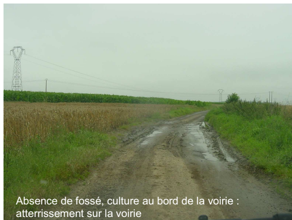
Atterrissement en entrée de champ en bas d'une forte pente
