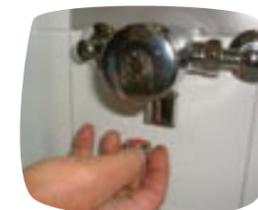
Ces équipements permettent de **diviser la consommation d'eau par deux** sans modifier la sensation du jet. Faciles et rapides à monter, ils ne nécessitent aucun entretien et s'adaptent à toutes les installations. Les foyers qui retirent un kit s'engageaient, en échange, à suivre leur consommation d'eau (relevé mensuel) pendant un an : les résultats montrent un gain annuel moyen de 10 %.
