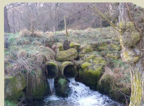
Buses à remplacer par un pont cadre sur le ruisseau du Tesche
