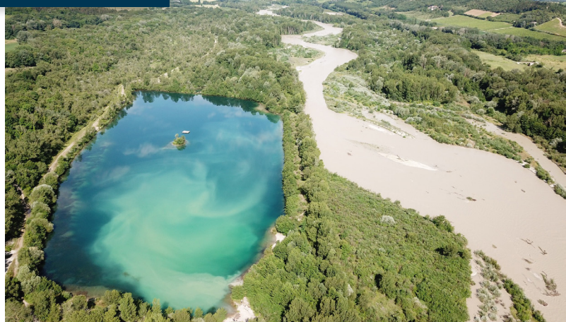
Photo du 7 juin 2018 montrant bien les infiltrations de la Drôme dans le lac des Freydières par la digue en mauvais état.
