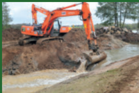
Mise en eau du nouveau lit (Vital/SMVV)
