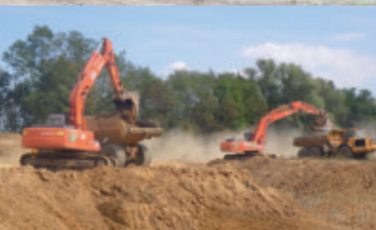
Creusement du lit (Corget/SMVV)
