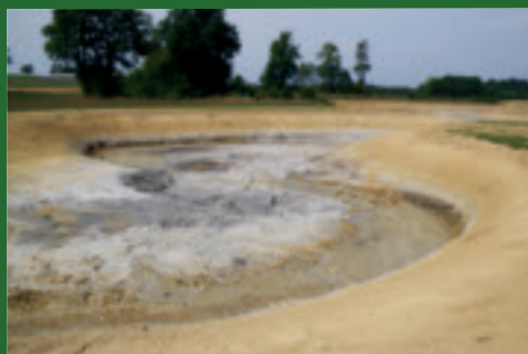
Nouveau lit nouvellement créé, avant mise en eau (Corget/SMVV)
