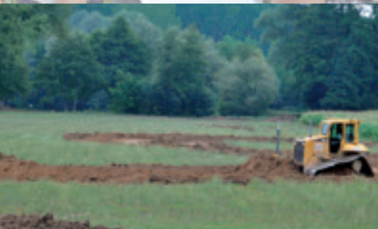
Tracé du lit au bulldozer (Vital/SMVV)
