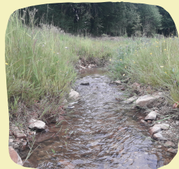
4. Continuité rétablie et site revégétalisé, sept 2022
