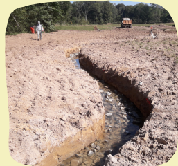
2. Terrassement et création du nouveau cours d'eau, sept 2021
